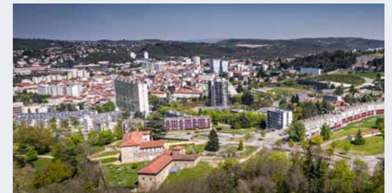
Les Tilleuls and Les Peupliers Buildings, 2018
